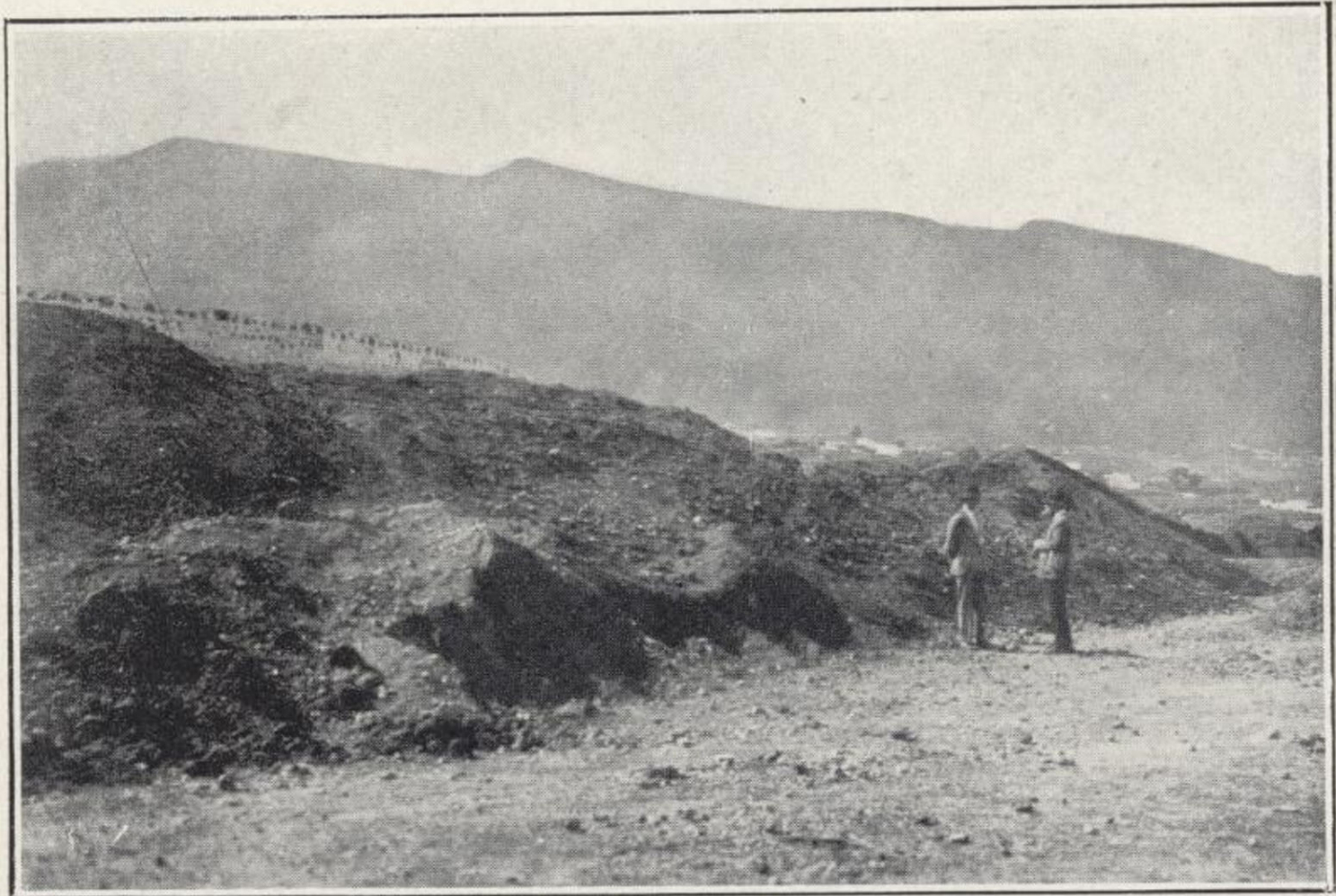
FOTOCRAFÍA NÚM. 5. — Capa de mina removida y preparada para extenderla sobre la capa de piedra partida de drenaje.
