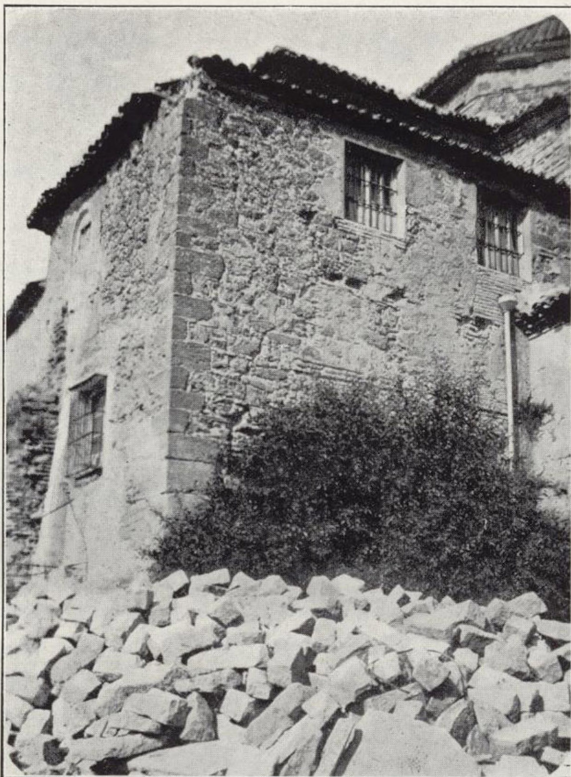
a) Montilla. — Ermita de San Juan de Dios. Grieta, desprendimiento y corrida del tejado.
