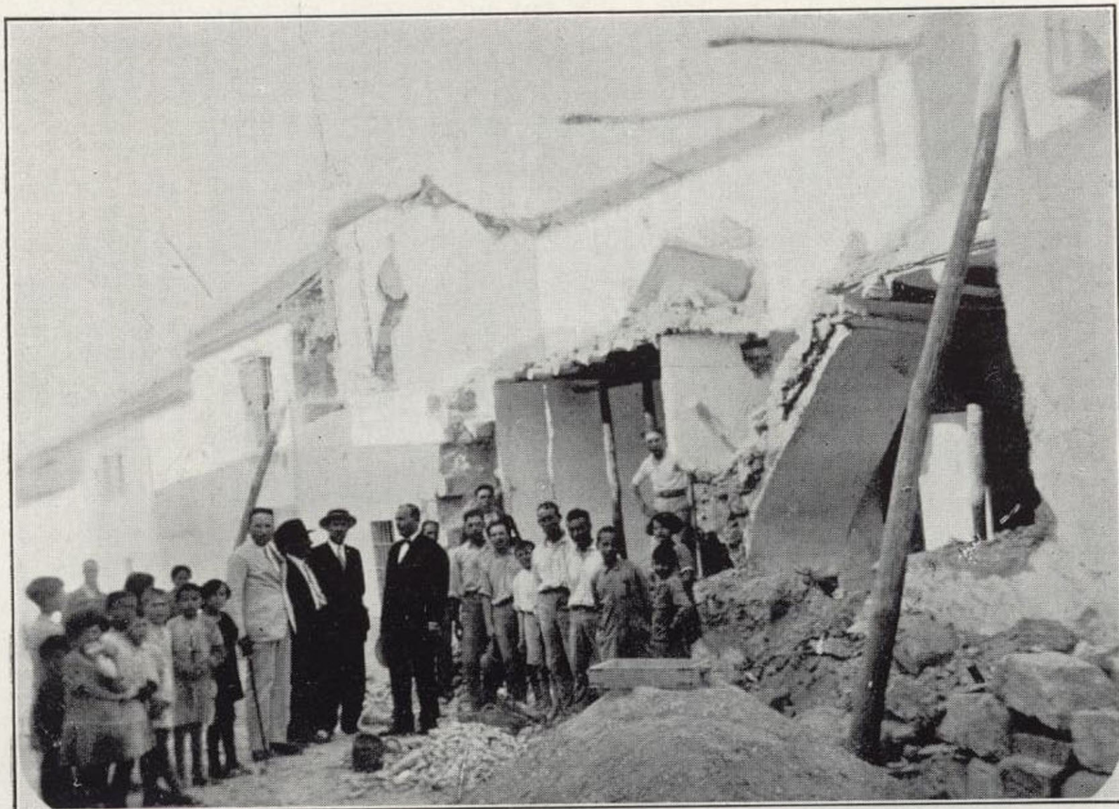
a) Montilla. — Calle de Santa Brígida. Hundimiento general; movimiento vertical dominante.
